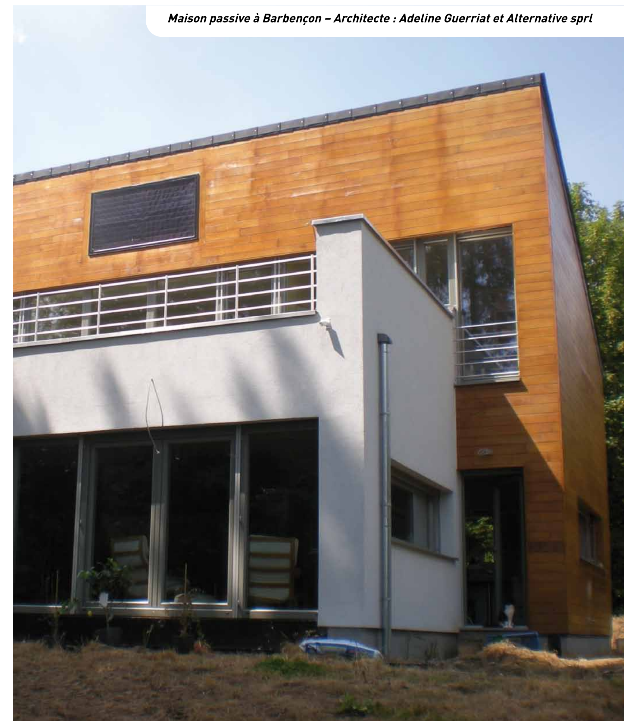
Maison passive à Barbençon - Architecte : Adeline Guerriat et Alternative sprl
